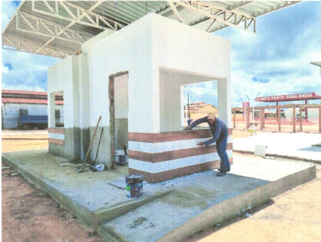
FOTO 08 - APLICAÇÃO E LIXAMENTO DE MASSA LÁTEX EM PAREDES, UMA DEMÃO.
