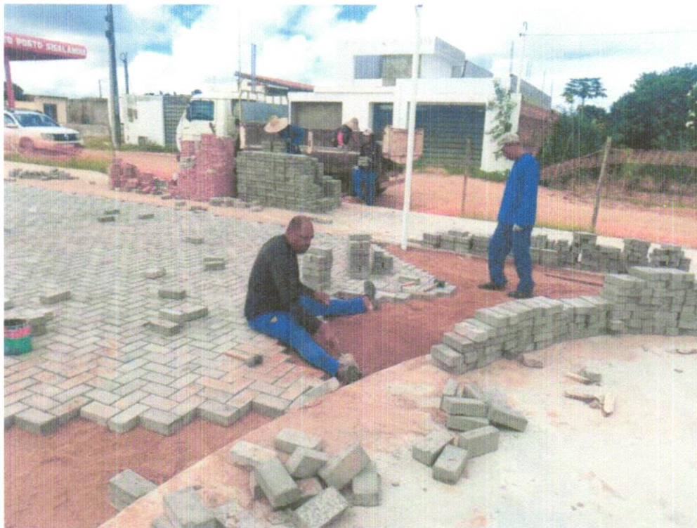
FOTO 04 - EXECUÇÃO DE PÁTIO/ESTACIONAMENTO EM PISO INTERTRAVADO, COM BLOCO RETANGULAR COR NATURAL DE 20 X 10 CM, ESPESSURA 6 CM.
