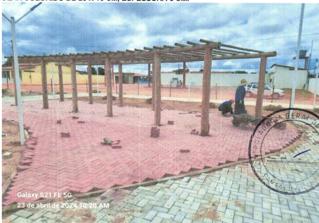
FOTO 06 - EXECUÇÃO DE PÁTIO/ESTACIONAMENTO EM PISO INTERTRAVADO, COM BLOCO RETANGULAR COLORIDO DE 20 X 10 CM, ESPESSURA 6 CM.
