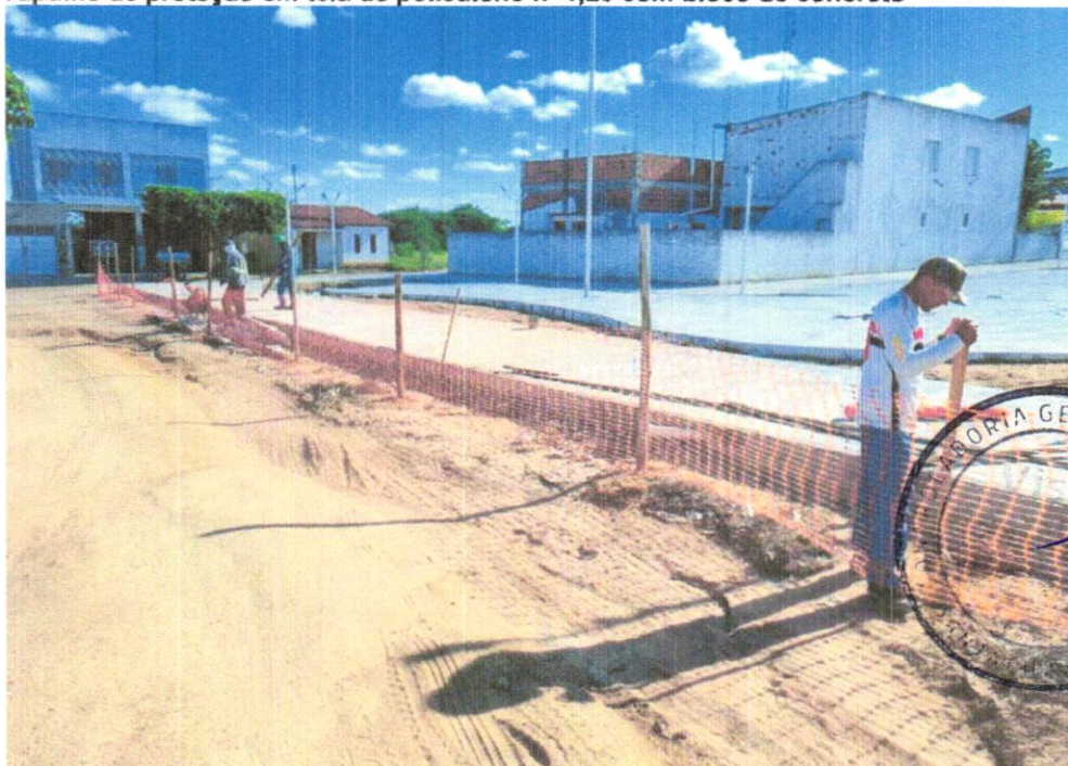
FOTO 02 - Tapume de proteção em tela de polietileno h=1,20 com bloco de concreto
