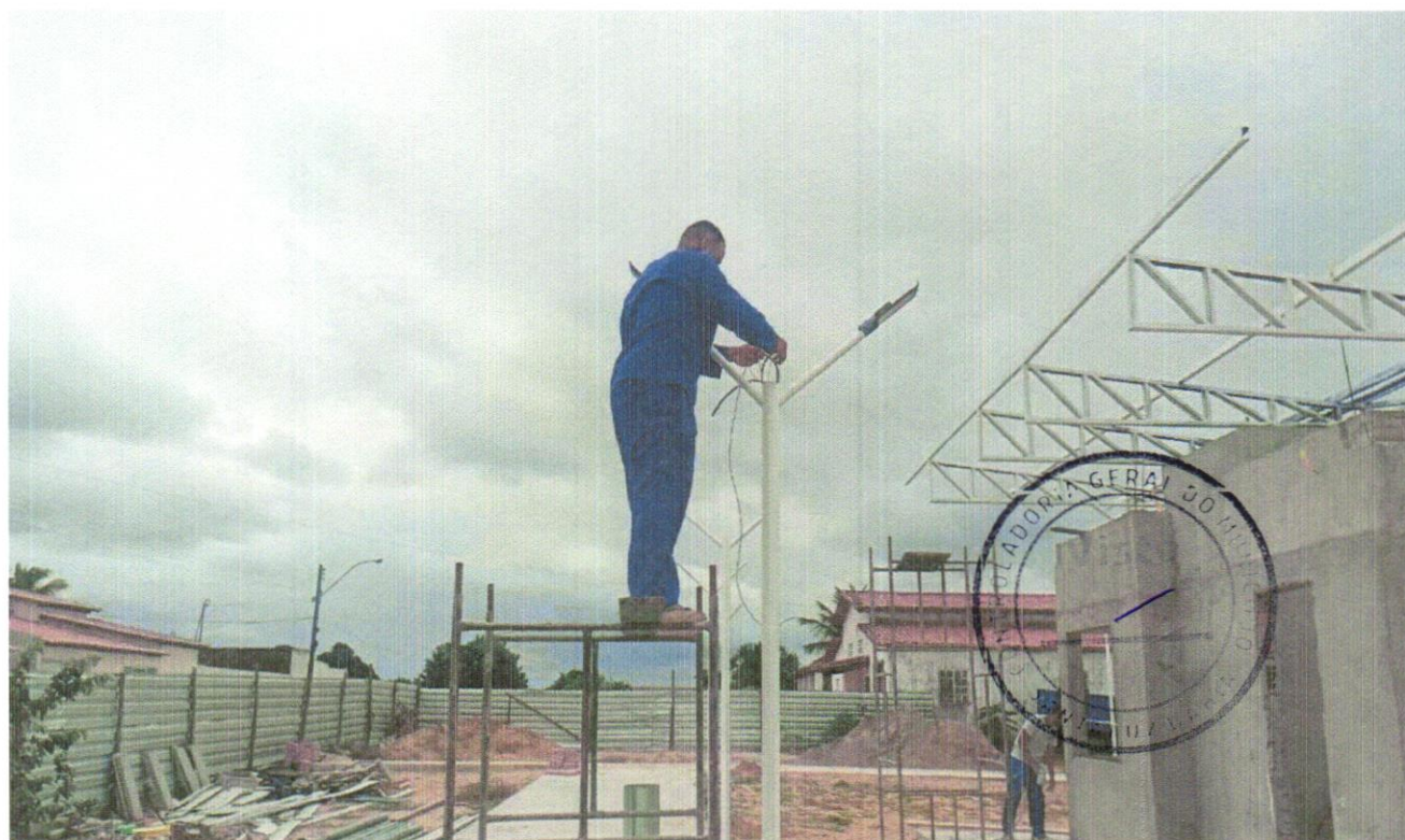
FOTO 10 - POSTE DE AÇO CONICO CONTÍNUO , ENGASTADO, COM QUATRO PÉTULAS
