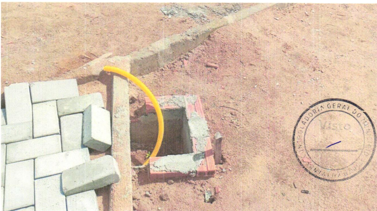
FOTO 14 - Caixa de passagem em alvenaria de tijolos maciços esp. = 0,12m, dim. int. = 0,30 x 0,30 x 0,30m
