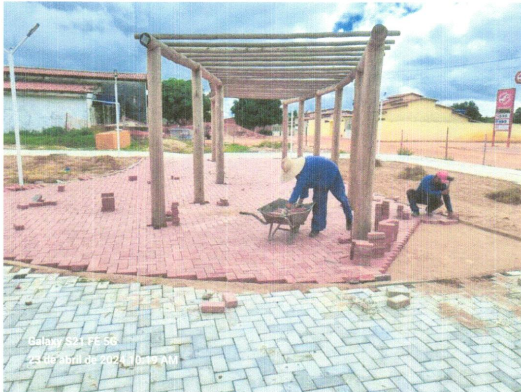
FOTO 06 - EXECUÇÃO DE PÁTIO/ESTACIONAMENTO EM PISO INTERTRAVADO, COM BLOCO RETANGULAR COLORIDO DE 20 X 10 CM, ESPESSURA 6 CM.
