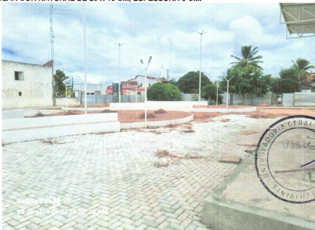
FOTO 04 - EXECUÇÃO DE PÁTIO/ESTACIONAMENTO EM PISO INTERTRAVADO, COM BLOCO RETANGULAR COR NATURAL DE 20 X 10 CM, ESPESSURA 6 CM.
