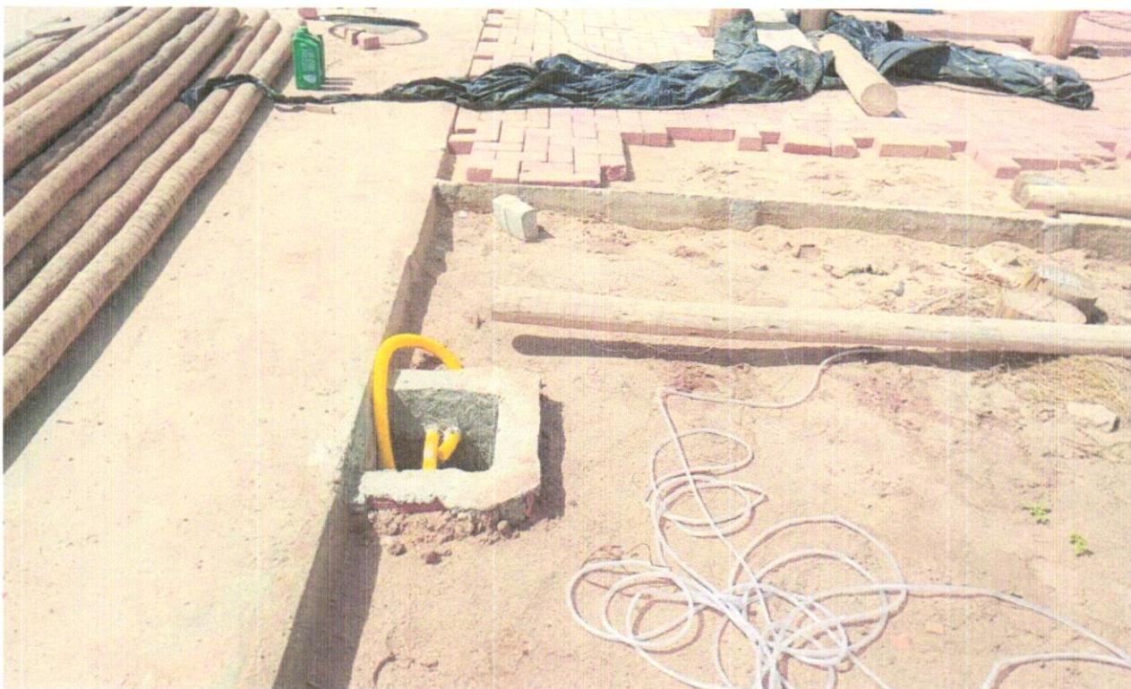
FOTO 14 - Caixa de passagem em alvenaria de tijolos maciços esp. = 0,12m, dim. int. = 0,30 x 0,30 x 0,30m
